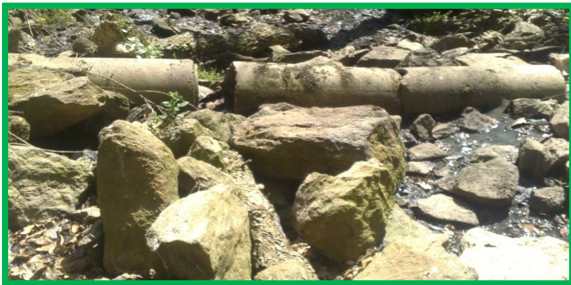
Figure IV.7 : Vue de rejet Oued Chioukh
