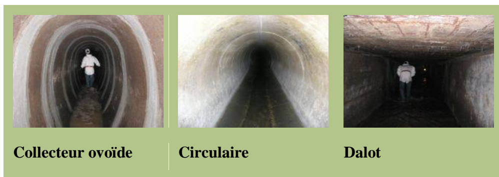
Figure VII.1 : Les ouvrages principaux
