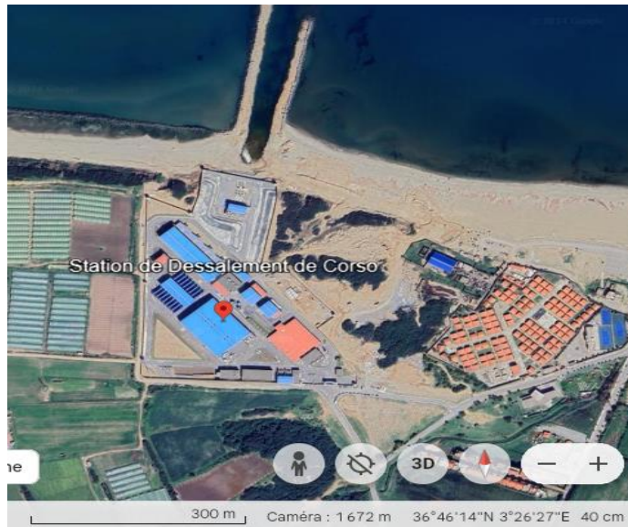
Figure IV- 1: Vue Google MAP sur la station de dessalement de Corso
