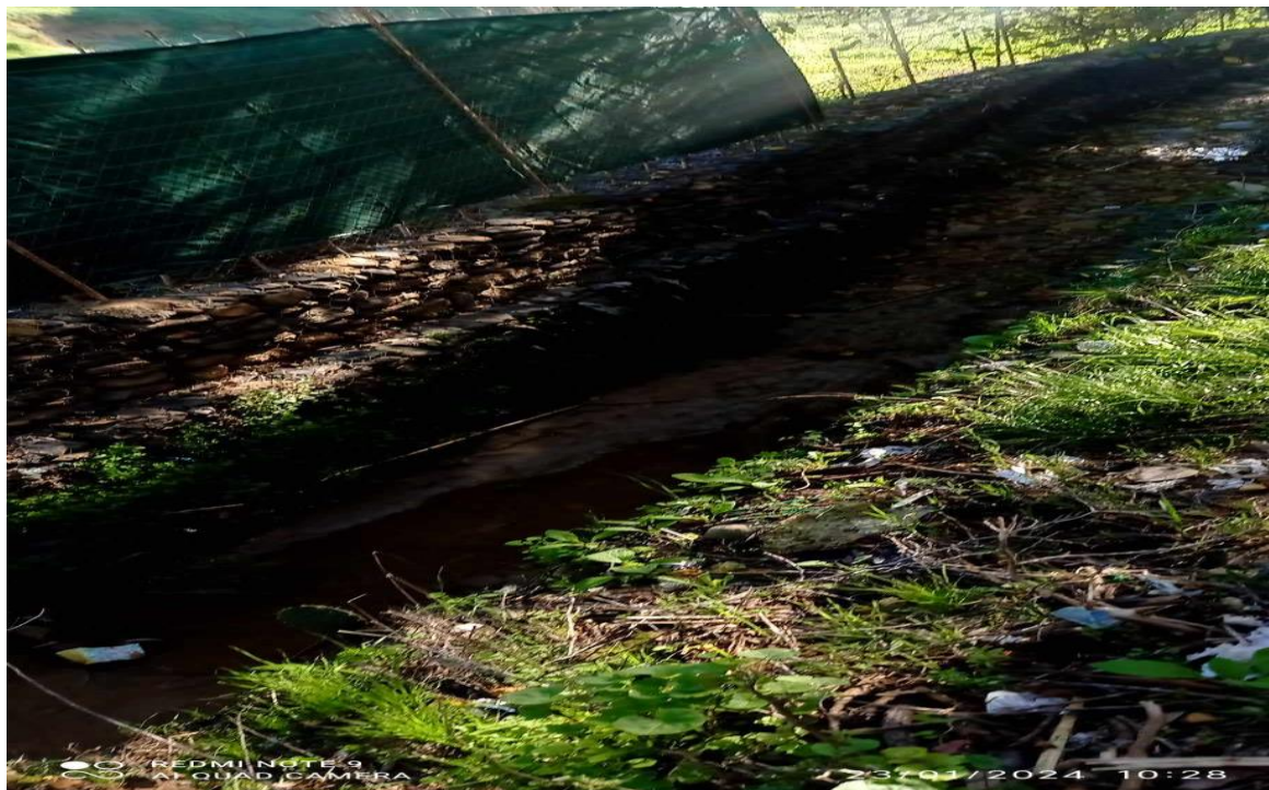
Figure IV.6: canal en gabions en zone d'habitation
