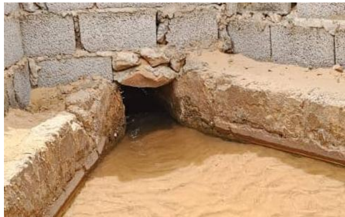
Figure 3.5: l'état actuel de la Kasria principale.
