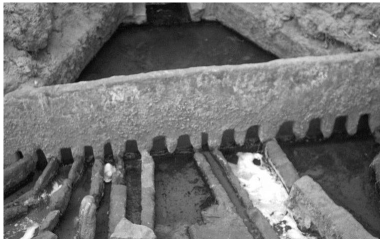
Figure 1.6: Kasria principe du foggara de l'oasis de Timimoun (Remini, et al 2015).
