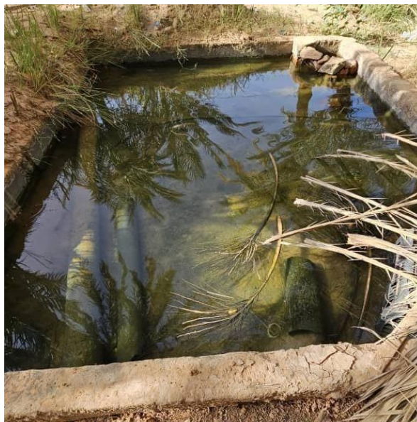
Figure 3.10: Un Madjen en ciment.
