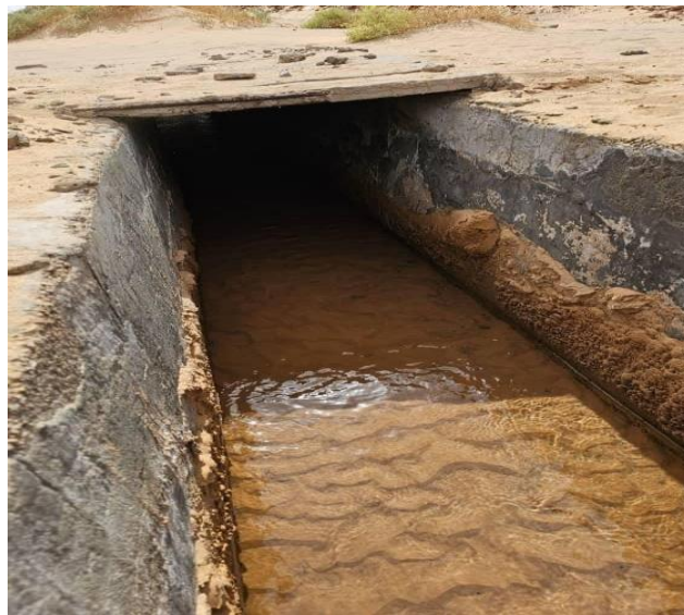
Figure 3.3: Photos sur terrain d'Aghisrou aménagé.
