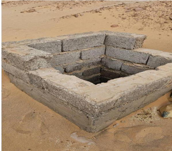
Figures 3.4: L'état des puits modernisés.
