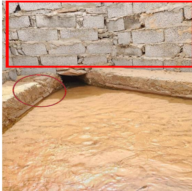
Figure 3.8: La Kasria principale aménagée.
