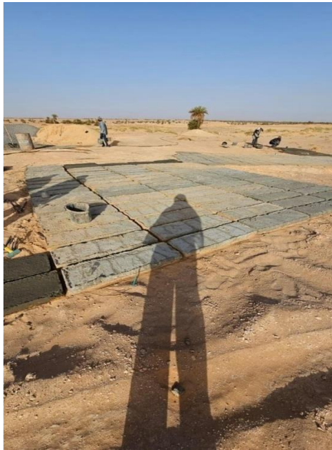
Figure 3.17: visite du projet d'aménagement de la Foggara.
