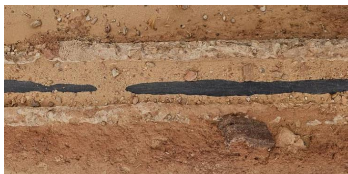
Figure 3.6: Une saguia ancienne remplacée par une conduite en PVC.
