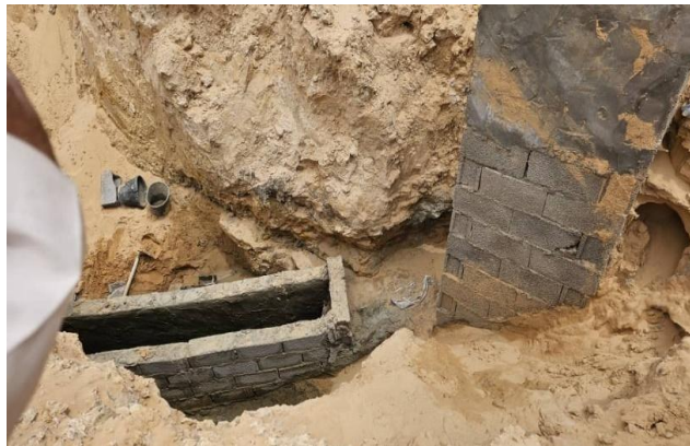
Figure 3.14 : visite du terrain.
