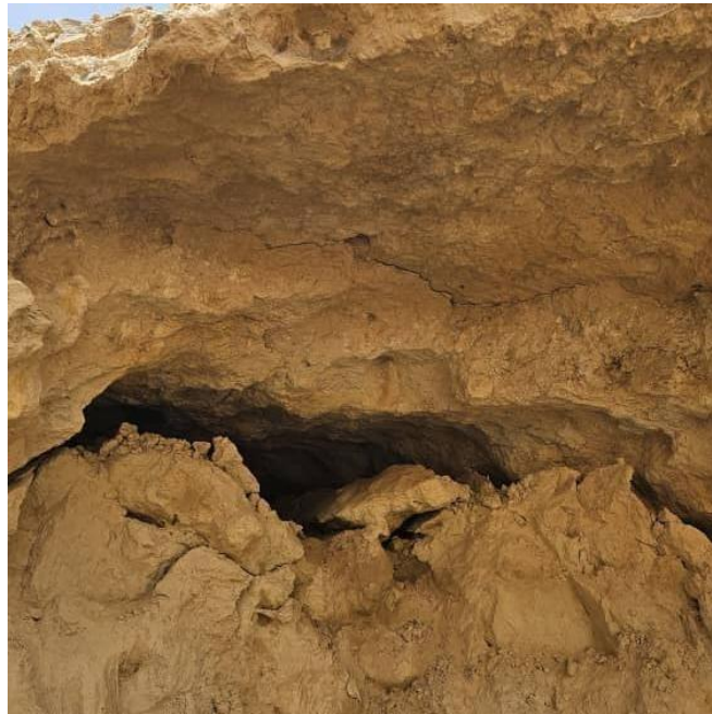
Figure 1.3: vue en coup du N'fad d'une foggara (2024)
