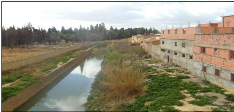
Figure IV.1 Absence des berges.
