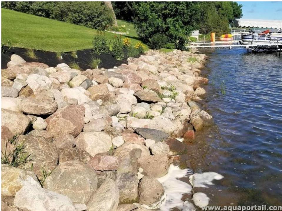
Figure IV-5 : Canal en enrochement
