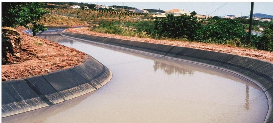
**Figure IV. 17 :** Canal en géomembrane.
