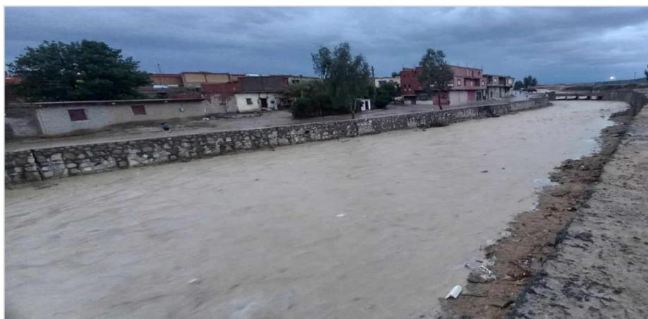
**Figure IV .18 :** canal mixte en enrochement et béton (m'sila)
