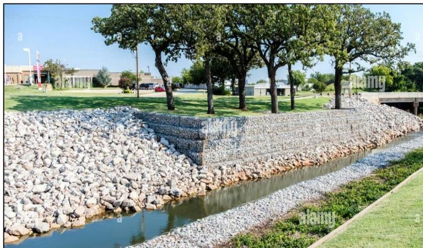
**Figure IV. 13** : Enrochement de canalisation (Source : Google).
