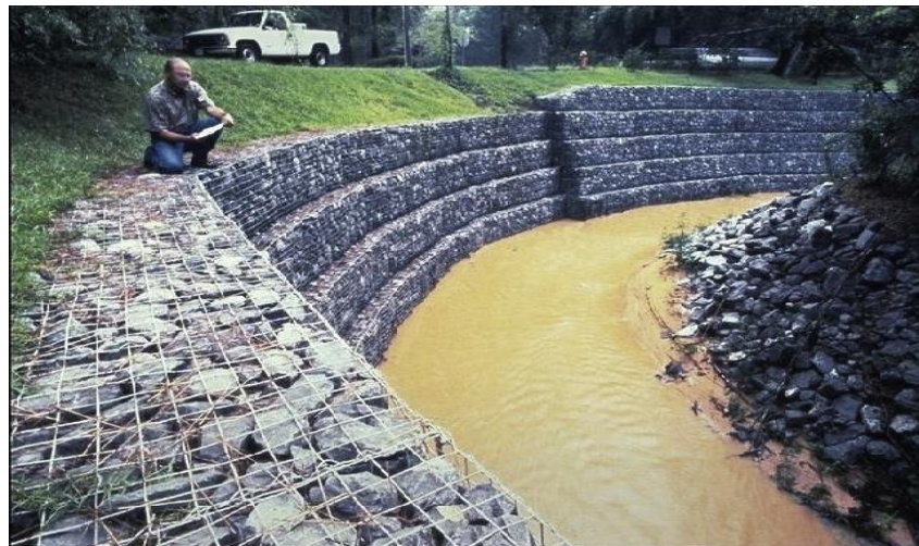
figure III-2 : Canal en gabion (Source : Google).
