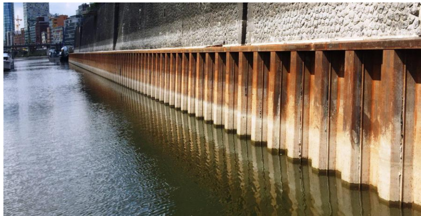
figure III-4 : Canal en Palplanches (source :Google)
