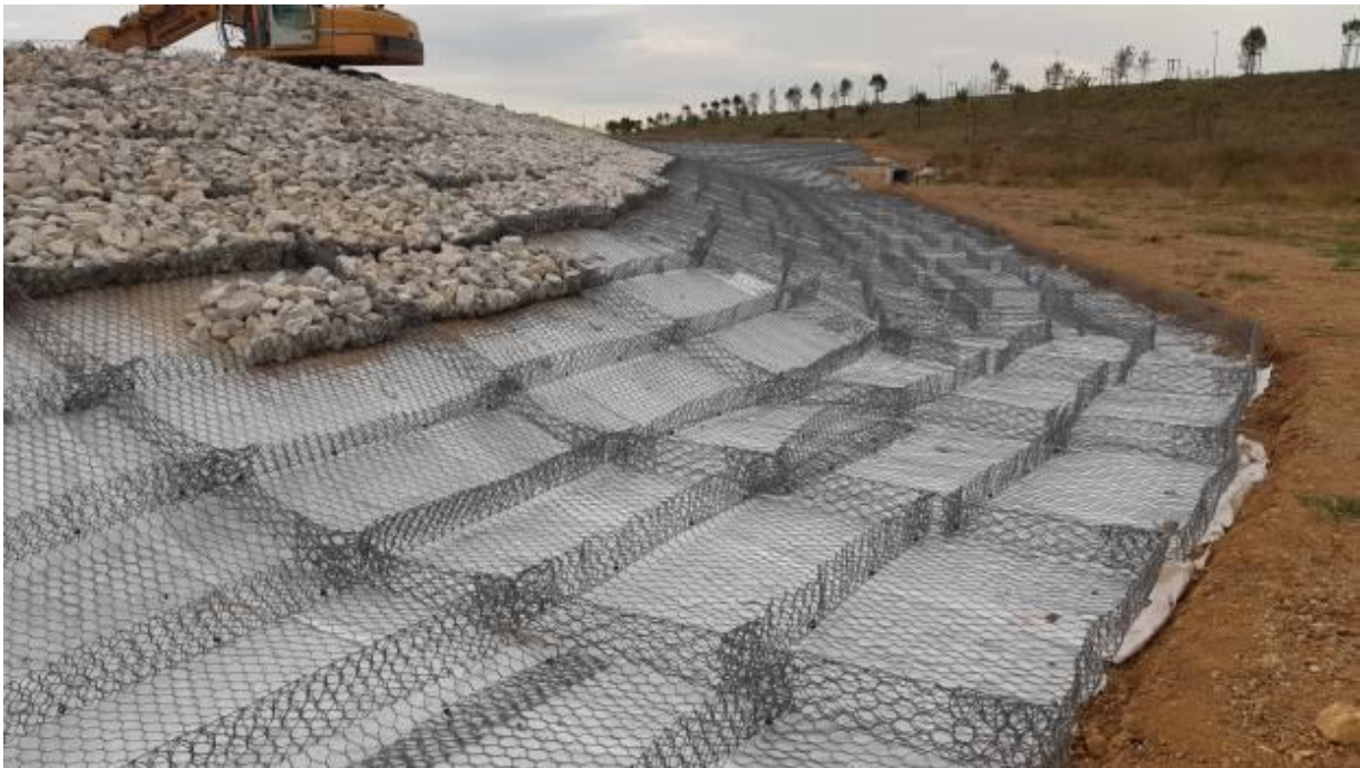
figure IV-8: canal en gabion avec fond en matelas reno
