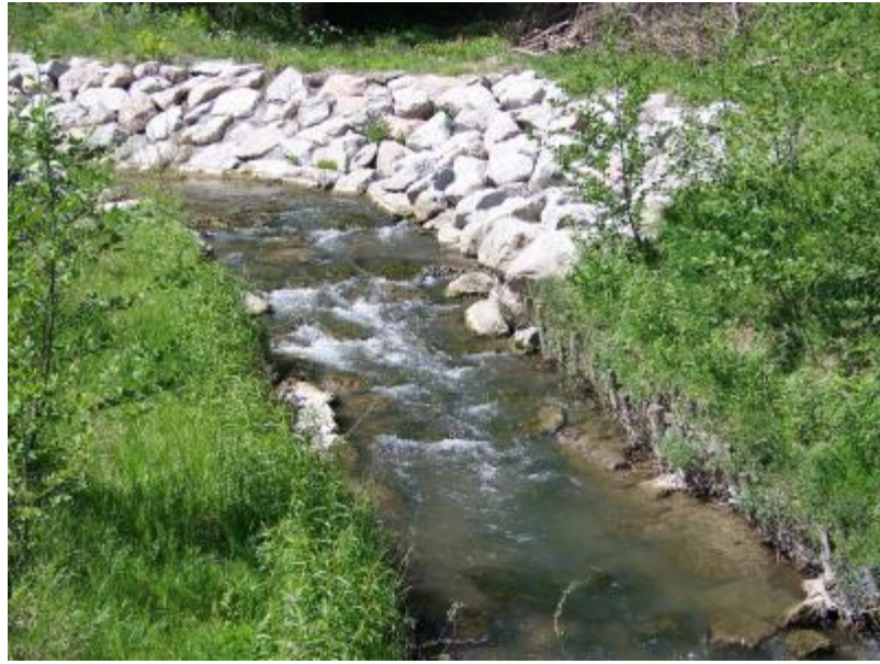
figure III-1: Canal en enrochement (Source : Google).
