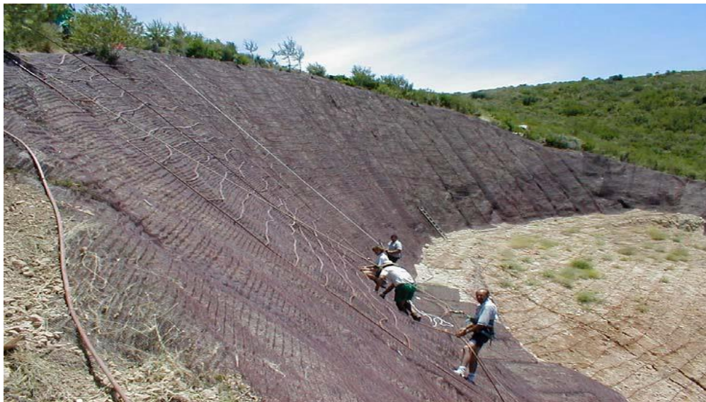
figure III-6: Canal en Géogrille (source :Google)
