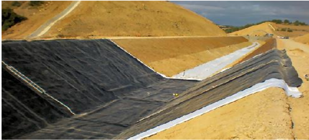
figure III-5: Canal en Géotextile (source :Google)
