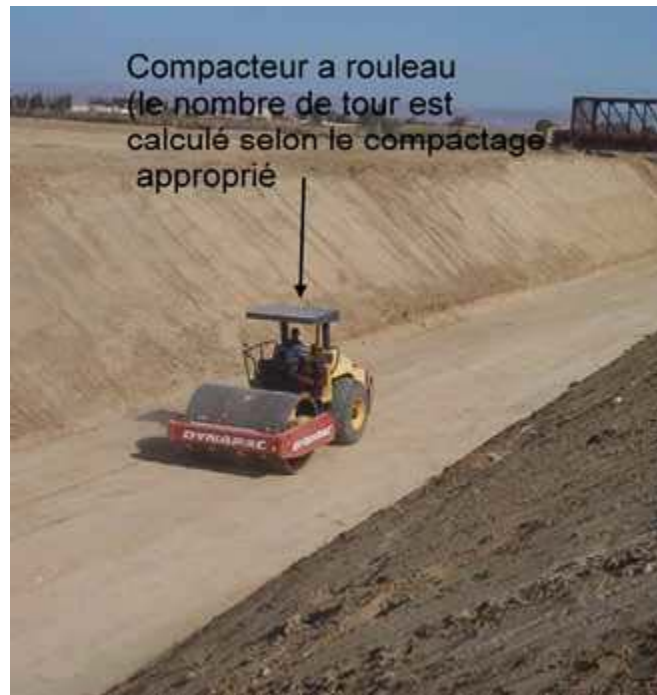
Figure VI.05 : Compacteur à rouleau lisse.
