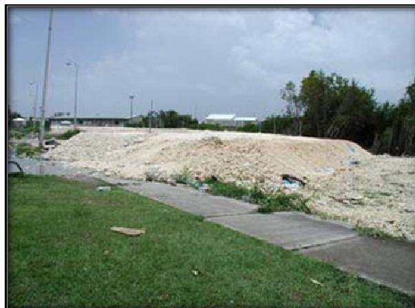
**Figure I.1 :** Préchargement d'un sol.
