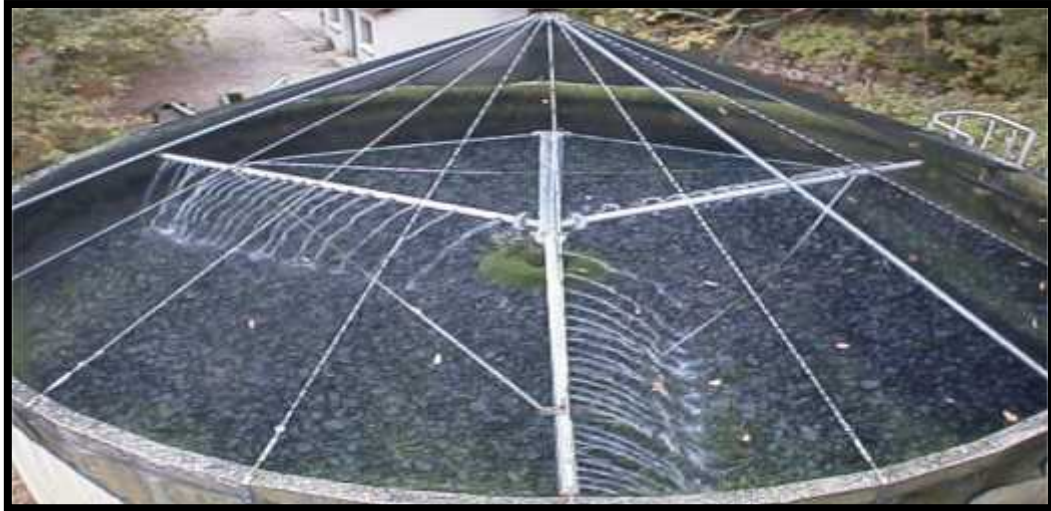
Figure II-6: Lit bactérien à remplissage traditionnel
