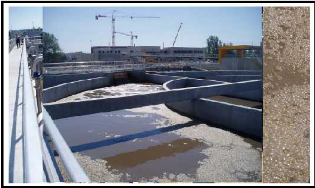
Figure II-9 : Bassin d'aération à boues activées
