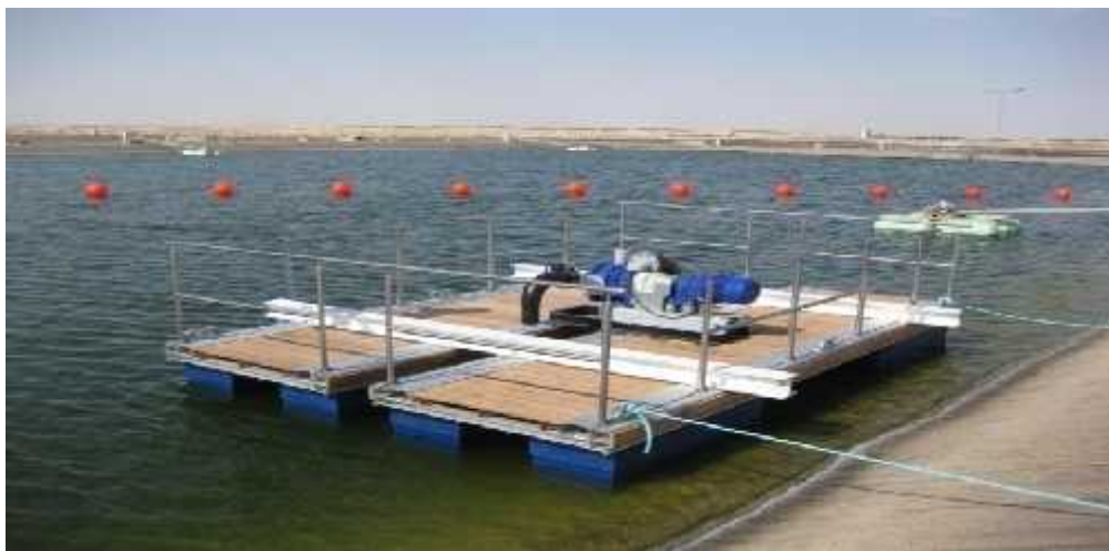
Figure III-5 : Radeau de curage des boues.
