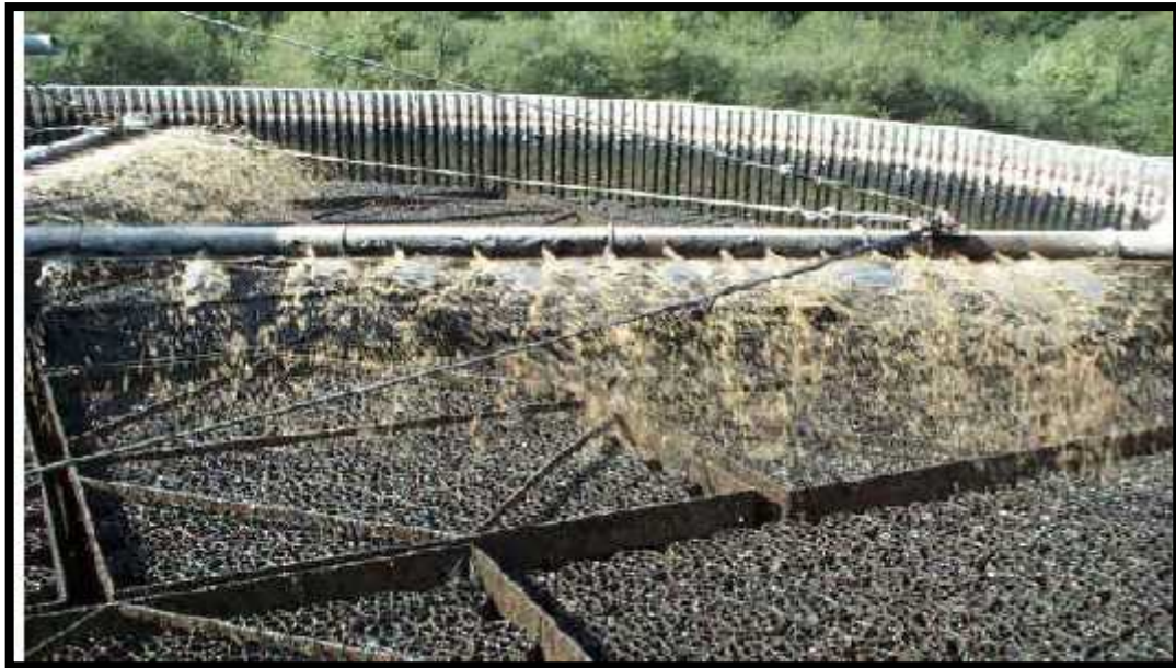
Figure II-7 : Alimention du lit bactérien (garnissage plastique)
