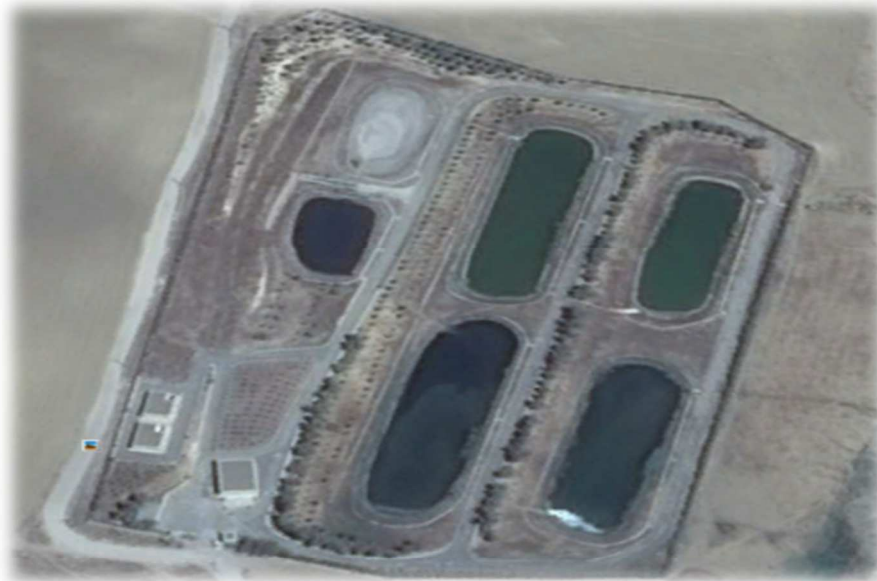
Figure 1 : Vue aérienne de la station de BENI FOU DA
