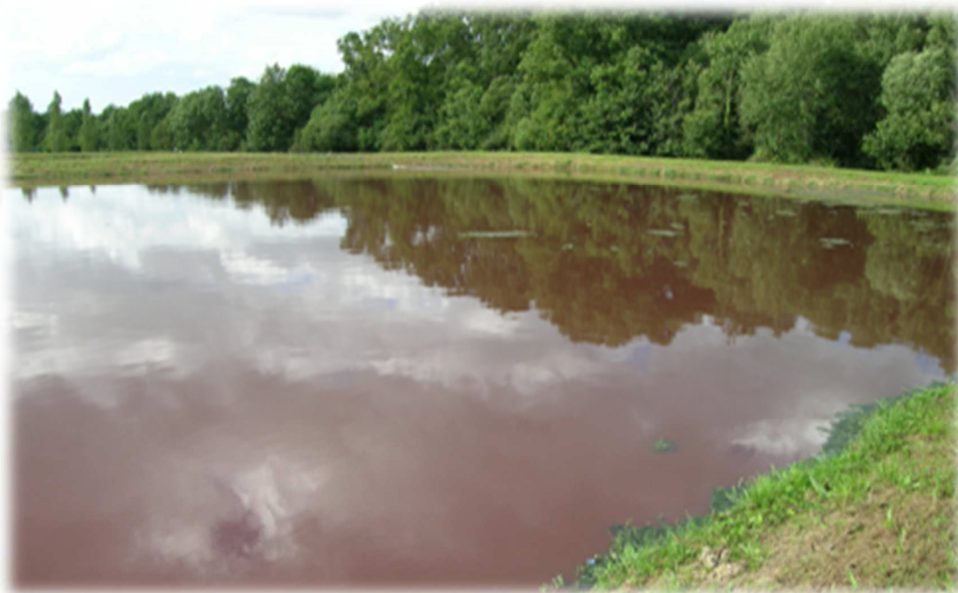
Figure V.2 Exemple de dysfonctionnement (coloration marron de la lagune)
