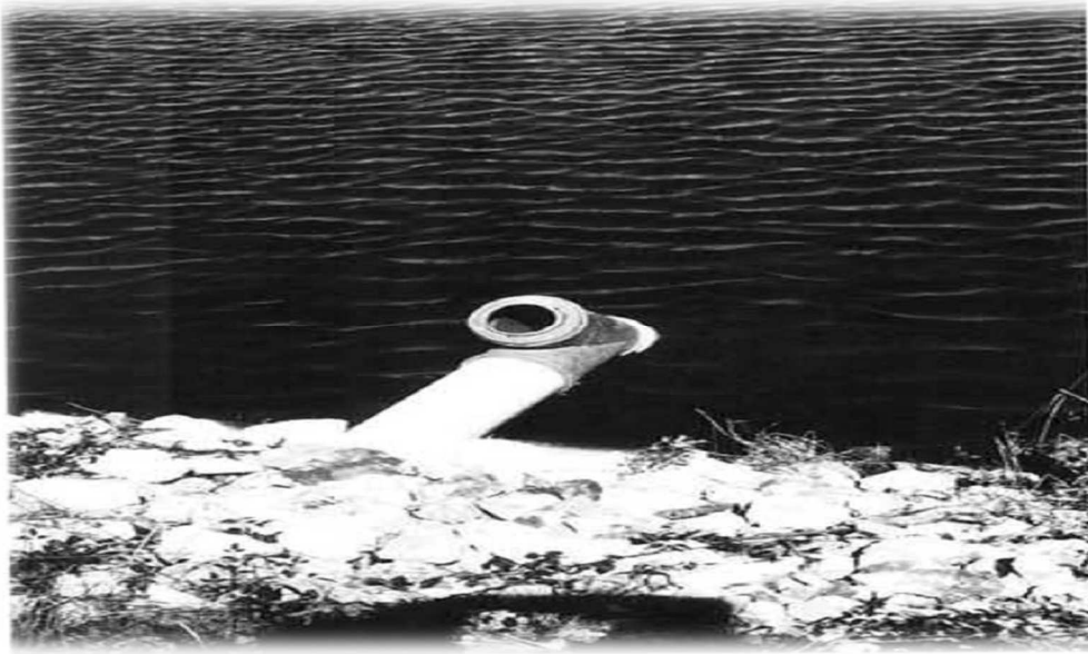
Figure V.5. Canalisation d'intercommunication entre les bassins
