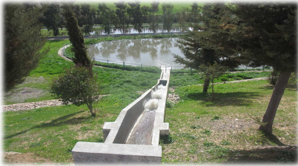
Figure 5 : Canal d'alimentation de la lagune facultatif
