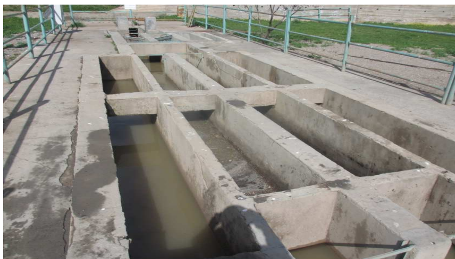
Figure III.2: Ouvrages de prétraitement
