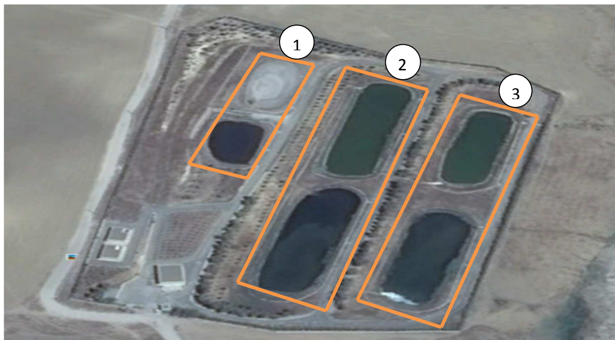
Figure III.1: Photo satellitaire de la station par lagunage de BENI FOUDA
