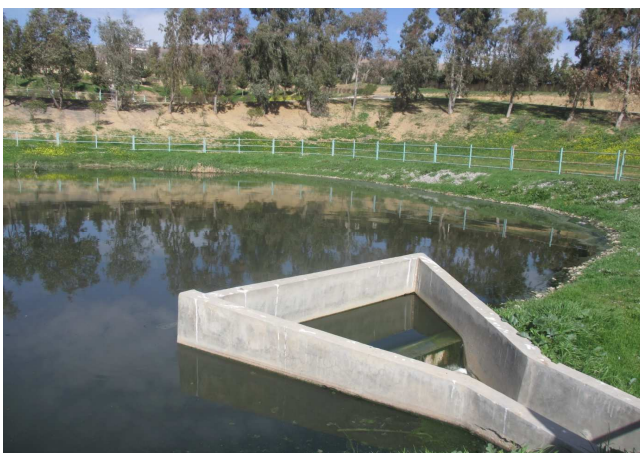
Figure 8 : Cloison du bassin de maturation
