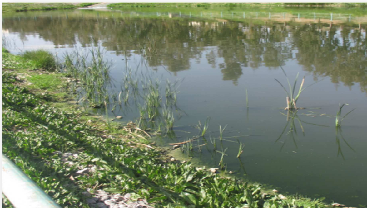
Figure V.3. Apparition des végétaux enracinés dans la lagune de la STEP
