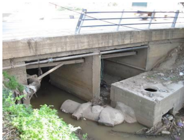
Figure IV.1 : Pont autoroute traversant Oued Guesbain
