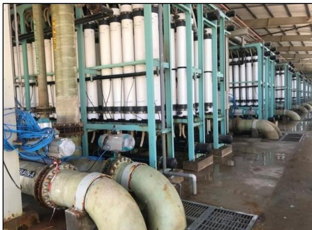
Figure IV.8 : Ultrafiltration -UF
