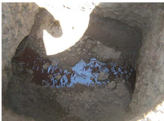
**Figure VI.8.**Regard rempli d'objets solides et avec un matériau non adéquat
