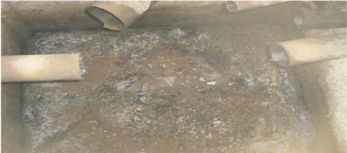
**Figure VI.3.** boîte de branchement réalisée sur la conduite
