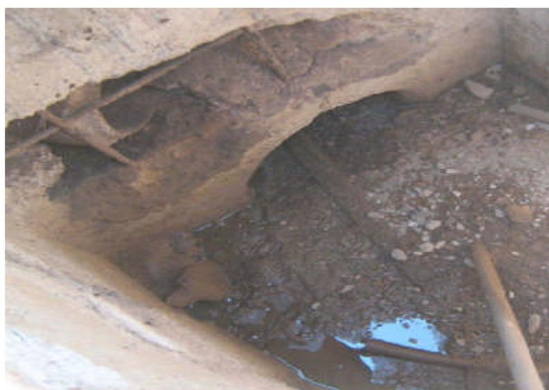
**Figure VI.6.**Regard envasée d'objets solide avec ferrailage apparent
