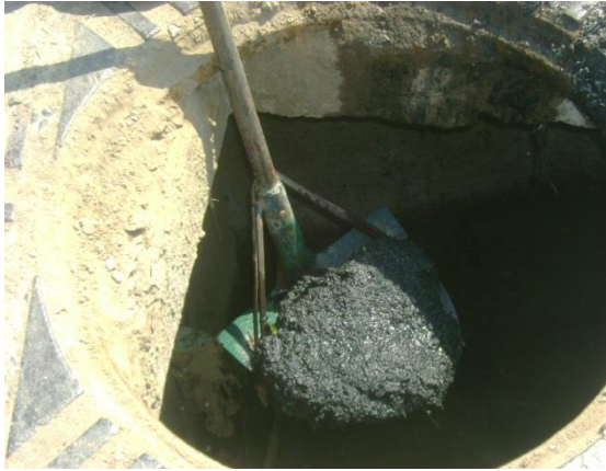
Figure VI.1 : l'extraction des boues
