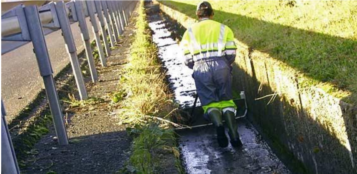
Figure VI.3 : Curage de caniveau
