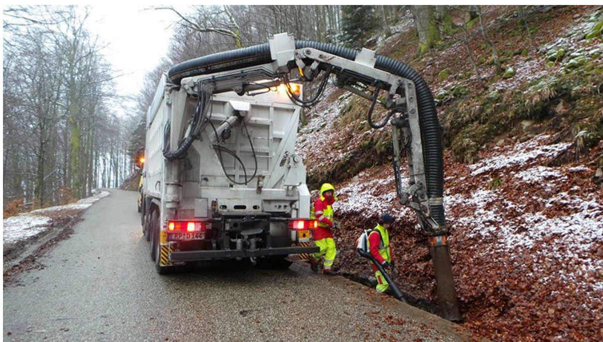
Figure VI.5 : Curage par aspirations
