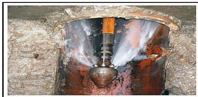
Figure VI.4 : Curage par boule
