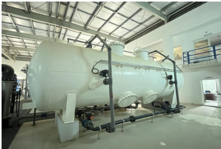
Figure IV.3. Les filtres à sable de la station d'IFRI.
