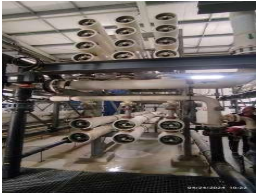
Figure IV.8. Le placement des membranes de la station par étage.
