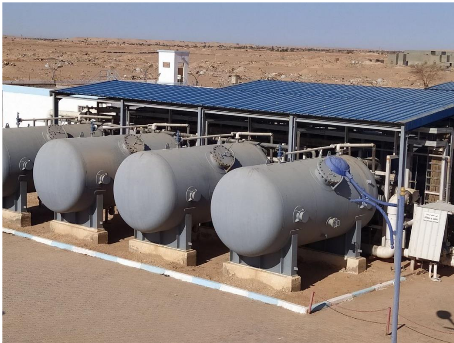
Figure III-3 : Filtre à sable.
