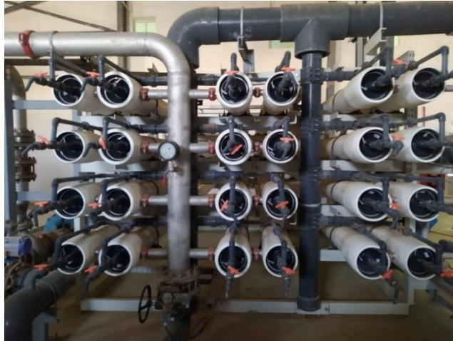
Figure III-5 : Unité d'osmose inverse.
