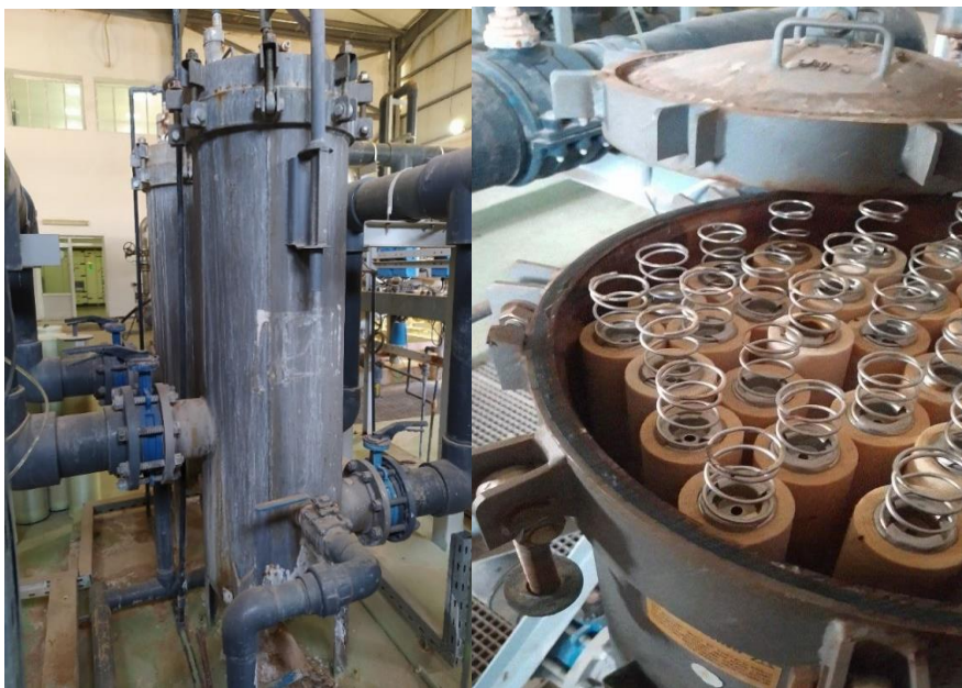
Figure III-4 : Filtre à cartouche.
