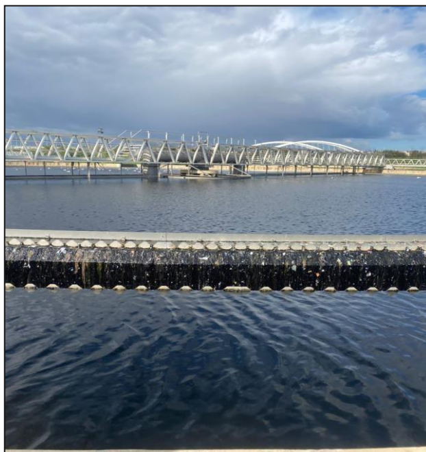
Figure III.6 : Photo du décanteur primaire de la STEP prise par (MAHIZI Anis, 19/02/23).
