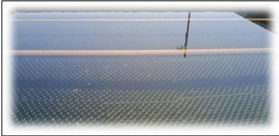
FIGURE IV.30 : DECANTEUR LAMELLAIRE.
