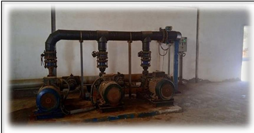
**FIGURE IV.39 : SYSTEME DE POMPAGE DE REFOULEMENT.**
