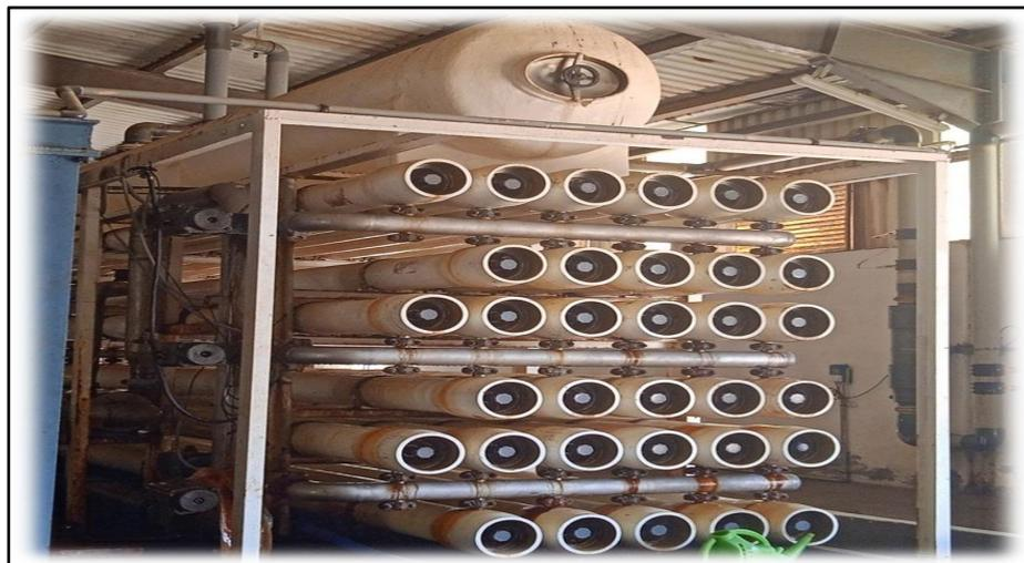
**FIGURE IV.36 : UN RACK DANS LE SYSTEME RO.**
