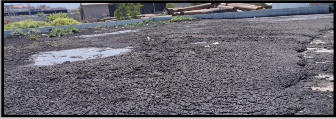
Figure I.15: Zone de stockage des boues déshydratées (Photo prise à la STEP de Beni Mered)
