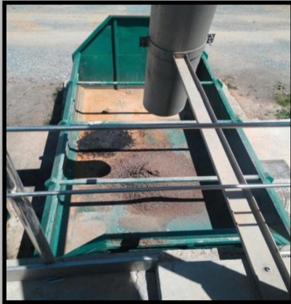
Figure I.10: Stockage des Sables (Photo prise à la STEP de Beni Mered)
