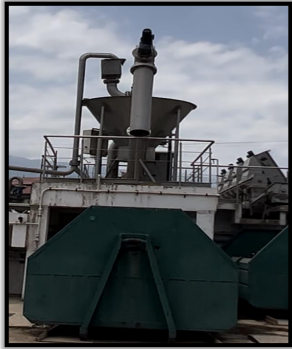
Figure I.7: Ligne de dessableur– déshuileur (Photo prise à la STEP de Beni Mered)
