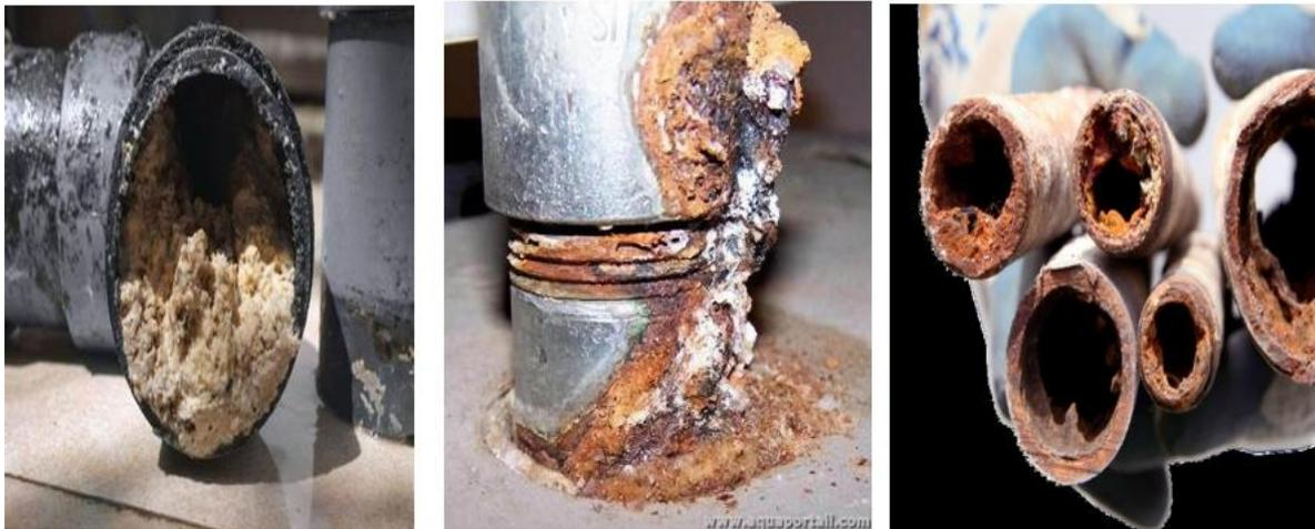
Fig. III.3 : Conséquences des eaux agressives sur les réseaux de distribution. [10]
