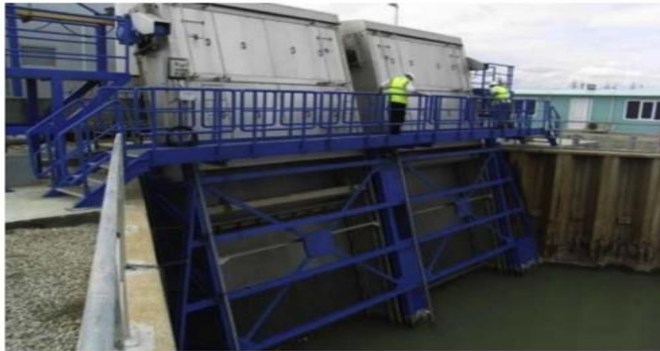
Figure 16 : Tamis grossiers de prise d'eau terrestre. [27]
