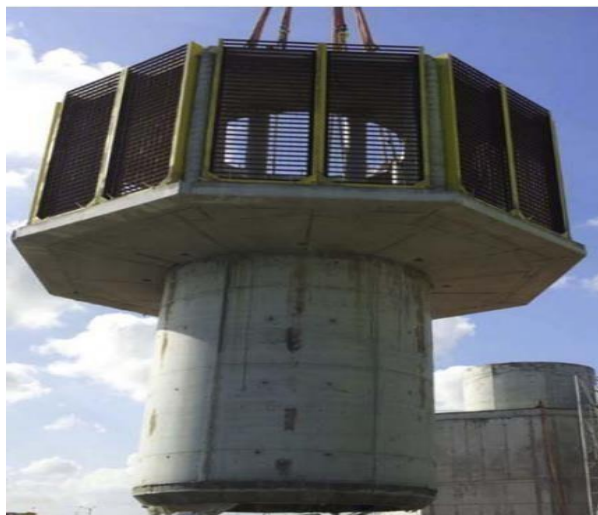
Figure 15: Tour d'admission verticale avec tamis grossier. [27]
