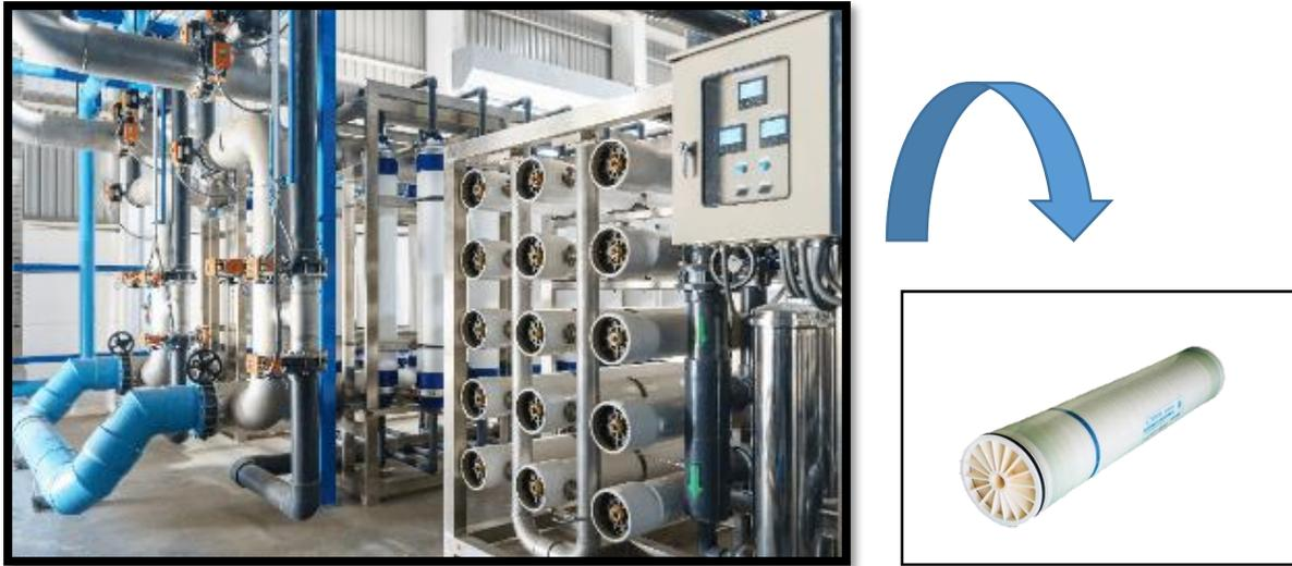
**figure II .6.** Skid composé de plusieurs membranes
