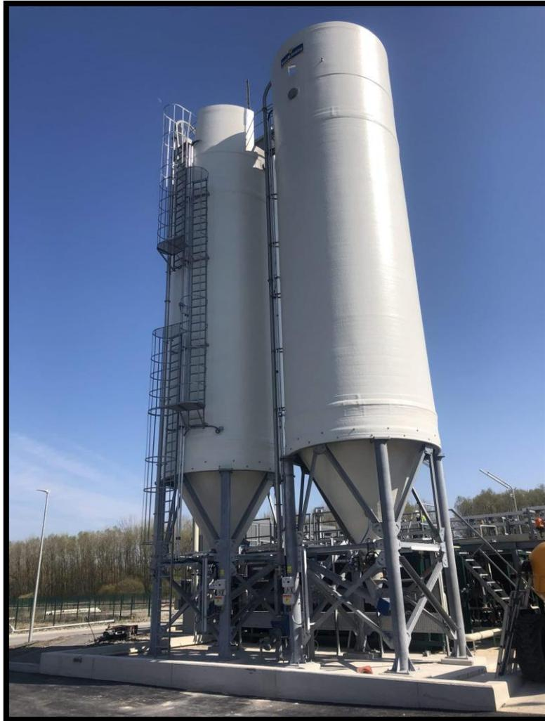
*figure III .2. Réservoir de stockage de dioxyde de carbone*
