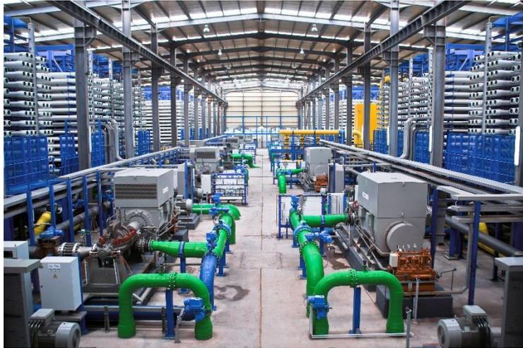
**Figure III.4 :** le système d'osmose inverse.
