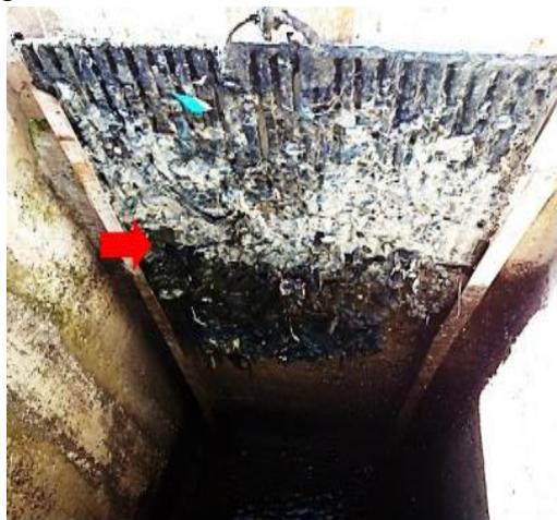
**Figure III.8 :** Etat structurelle du Le dégrilleur manuel
