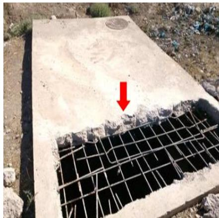
**Figure III.4** : Etat structurale du déversoir d'orage
