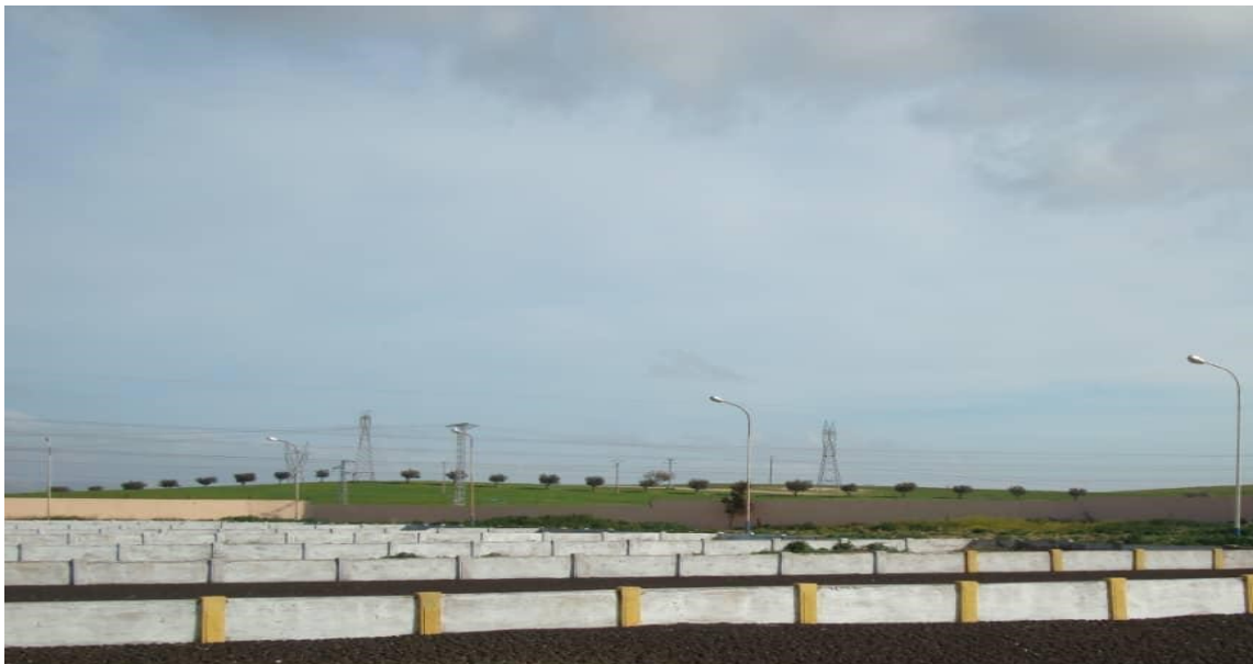
Figure IV.16 : Lits de séchage de la STEP.
