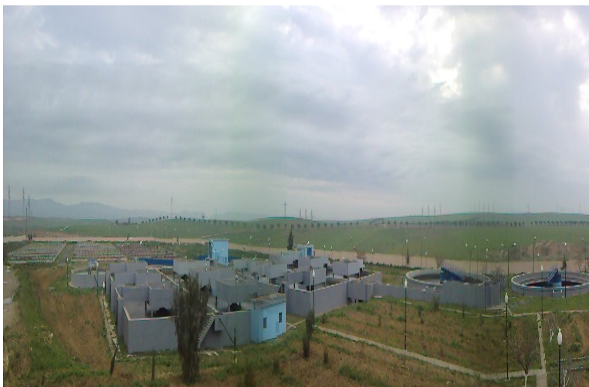
Figure IV.1 : Photo de la station d'épuration de SBA (STEP SBA,2024 ).
