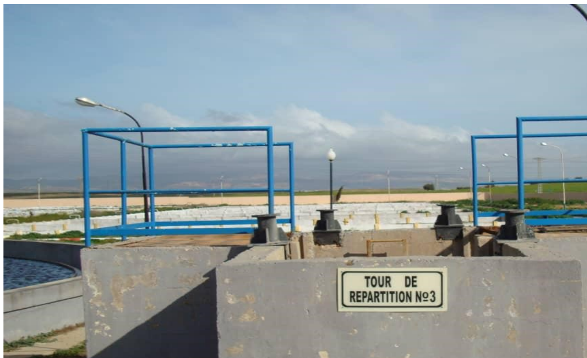
Figure IV.10 : Tour de répartition N° 3 de la STEP
