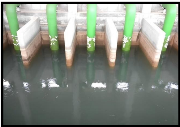
Figure III-3 : Bassin de stockage
