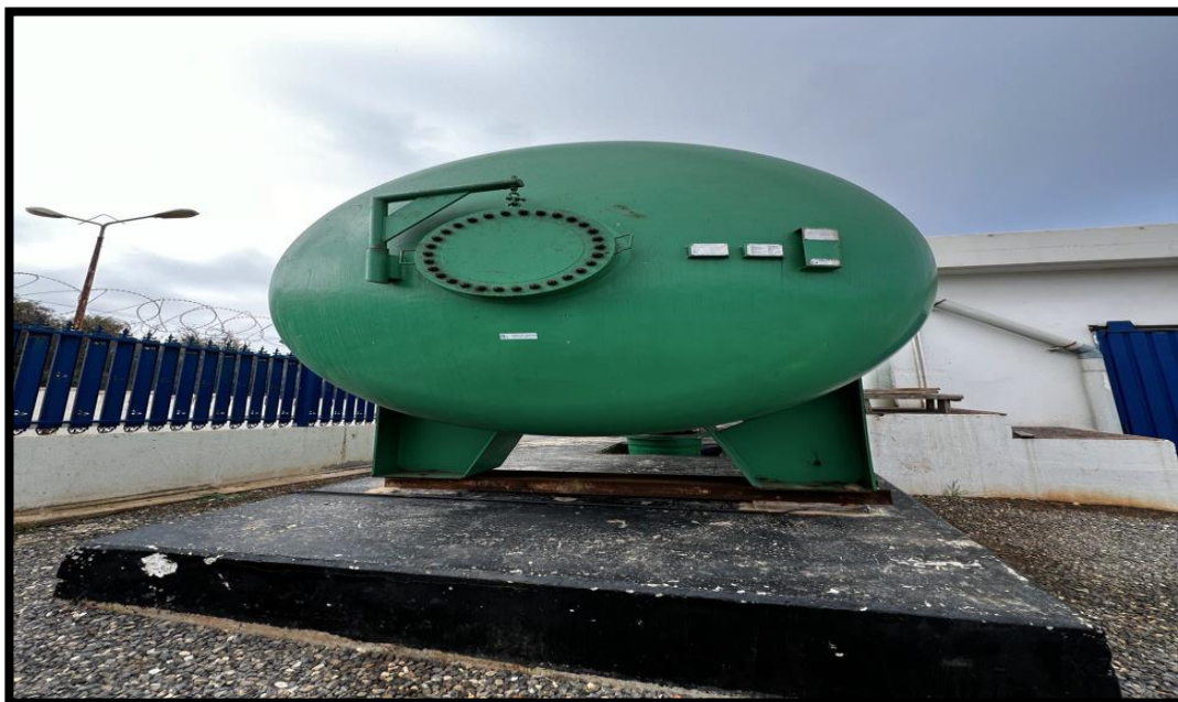
Figure IV.11 : le réservoir anti coup bélier
