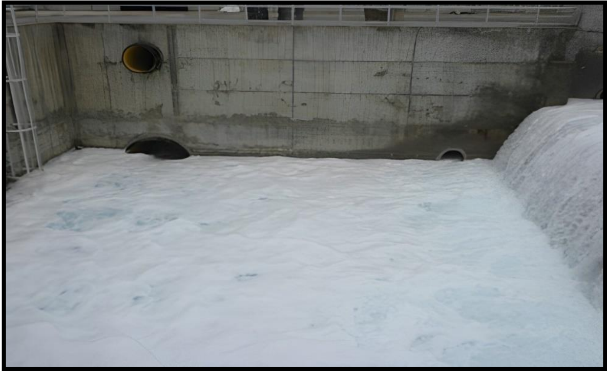
Figure III-11 : Rejet de saumure vers la mer
