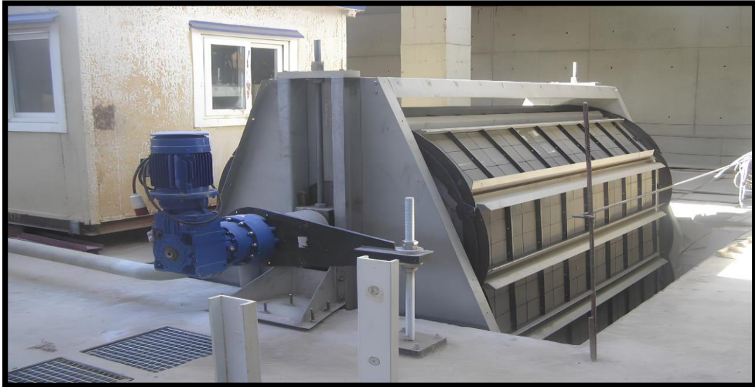
Figure III-5 : Le filtre rotatif
