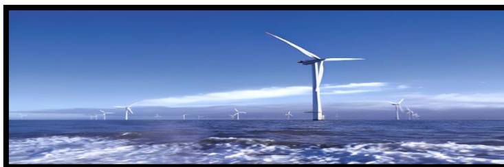
Figure VI-11 : Parc d'éoliennes offshore au Danemark [36]
