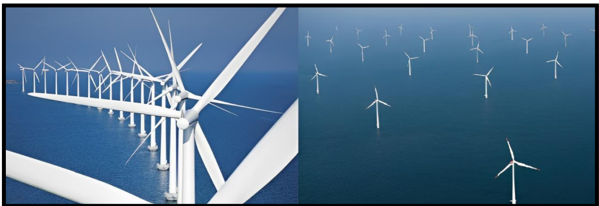
Figure VI-13 : Disposition de Parcs Eoliens Offshores en Arc de Cercle et en Quadrillage [36]
