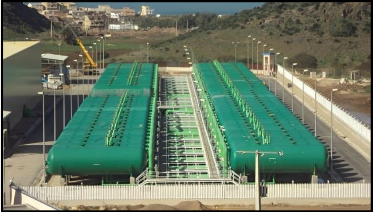
Figure III-7 : Ensemble des filtres à sable et à Anthracite
