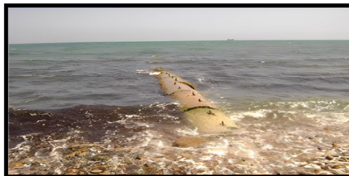
Figure II.6: Tuyau de captage de l'eau de mer (Ténès, willaya de Chlef). [18].
