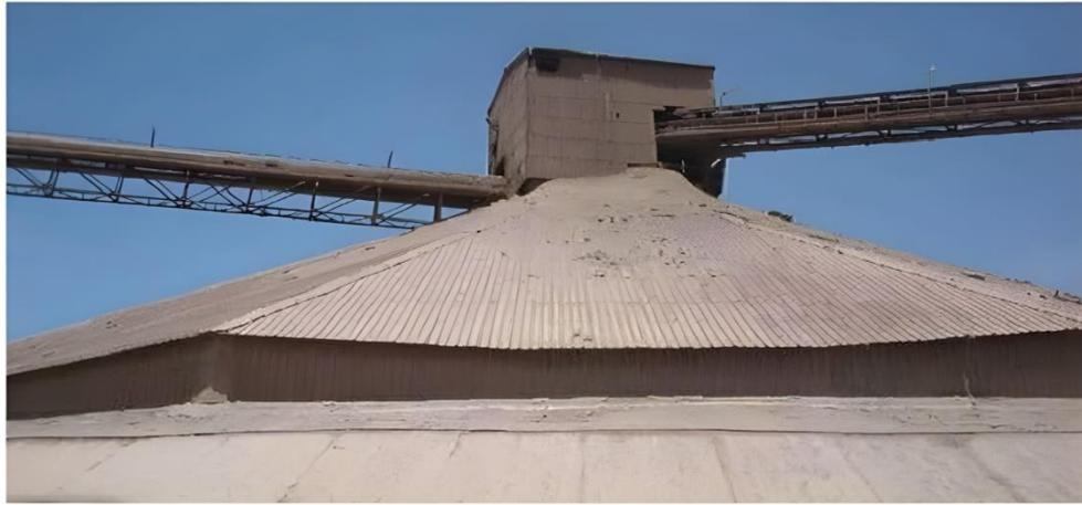
**Figure II-6:** Les bulles de stockage du clinker de la cimenterie de Béni-Saf.
