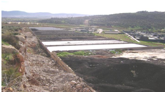
Figure II.12 : Aire de stockage [10].
