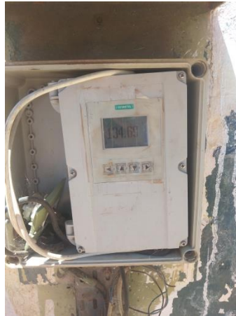
Figure III.14 : Débitmètre de la sortie (Mai ,2024)
