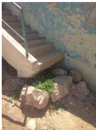
Figure III.15 : l'escalier de la chambre des moteurs vers des vis (Mai ,2024)
