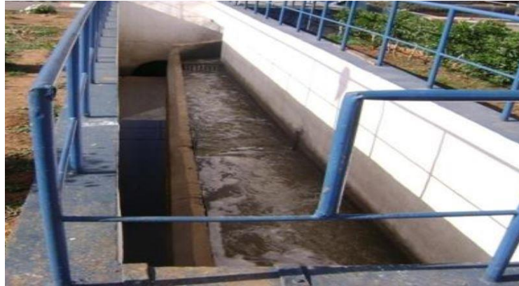
Figure II.2 : Déversoir d'orage [10]
