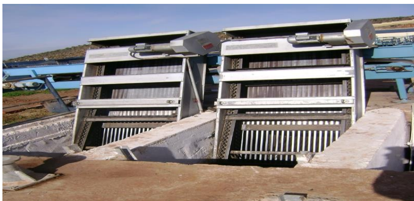
Figure II.4 : Les dégrilleur mécanisés [10].
