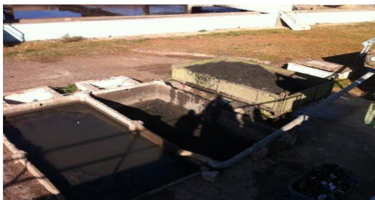
Figure II.6 : Les bacs à sable (2024).
