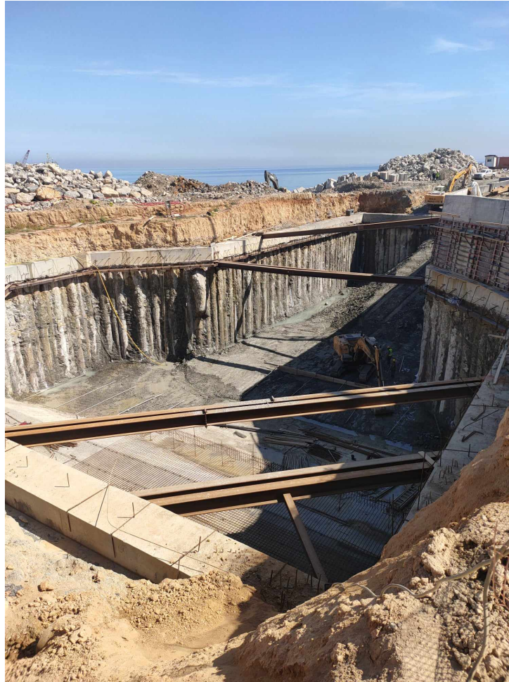
FIGURE 3.6 – Bassin de captage
