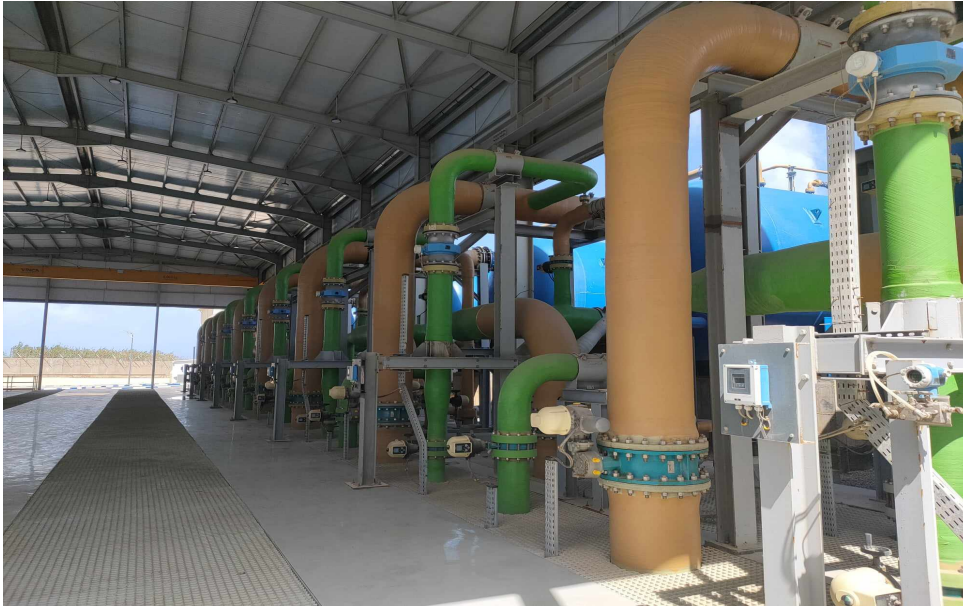
FIGURE 5.2 – Installation des filtres corso
