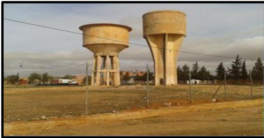
Figure III.2 : Châteaux d'eau de 300m<sup>3</sup> et 250m<sup>3</sup> (source DRE Tissemsilt)
