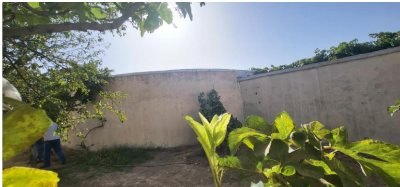
Figure III.11 : vue de l'extérieur du réservoir 500m 3
