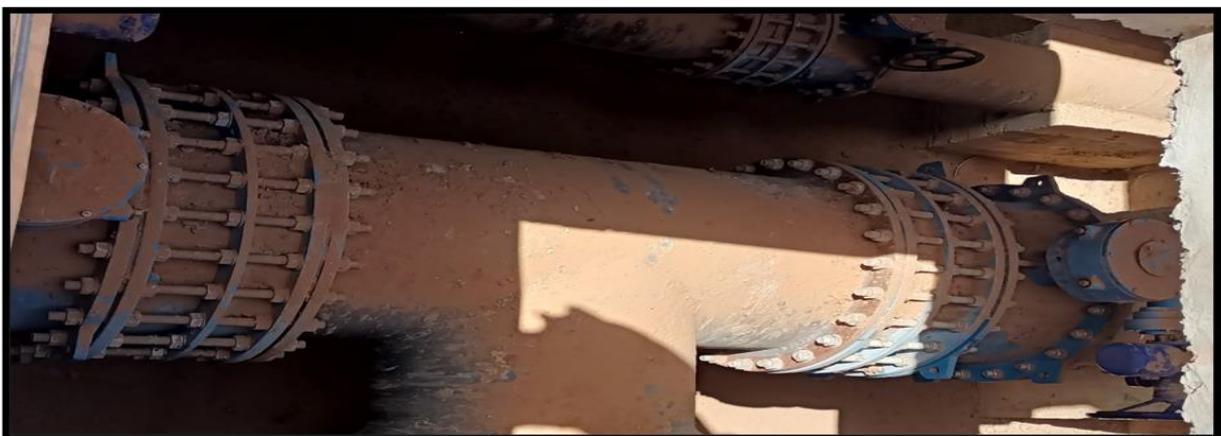
Figure IV.8 : Conduites de départ et de vidange + trop plein dans la chambre des vannes de R.OUEST
