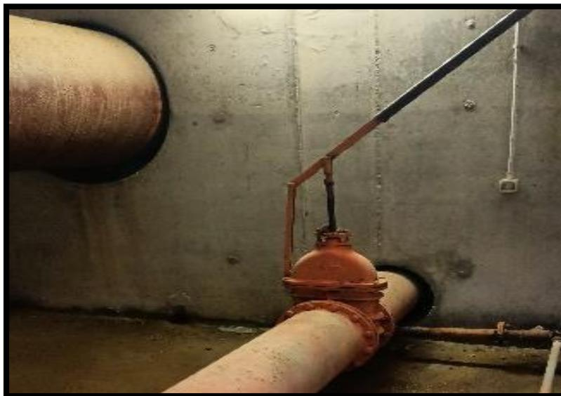
Figure III.4 : Conduite de départ et de vidange de la bache d'eau SP2.
