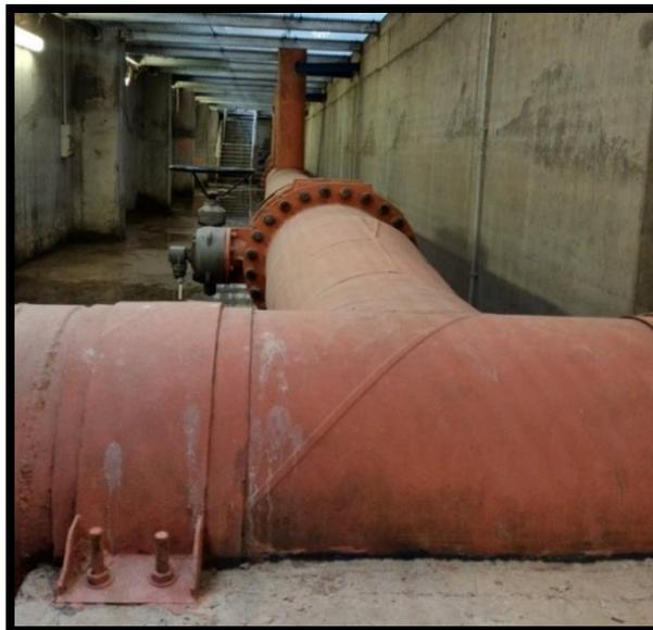
Figure III.2 : Conduite d'aspiration de SP01
