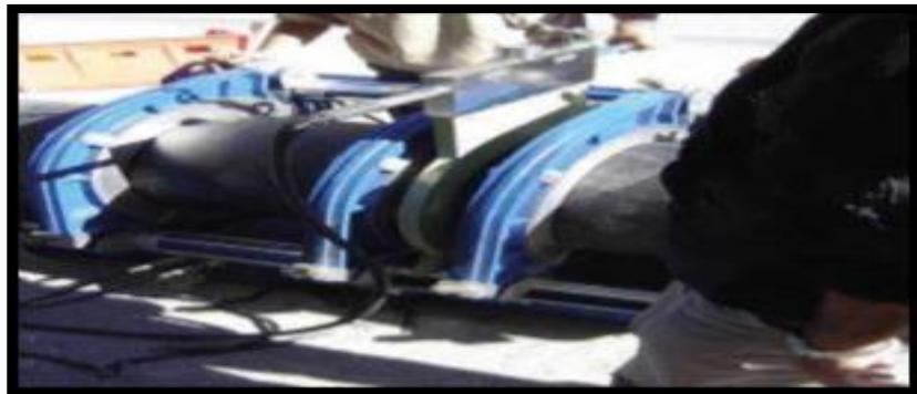
**Figure VI.11** : Le raccordement par soudage bout à bout. (Guide de pose des canalisations, STRPE)
