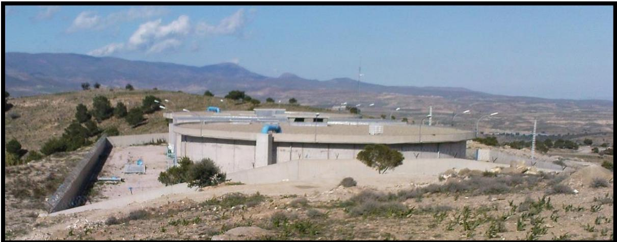
Figure IV.7 : Les réservoirs R-OUEST de  $2*5000 \text{ m}^3$
