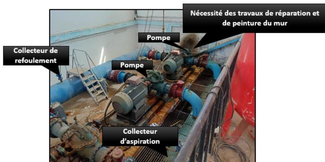
Figure IV.7 : L'état à l'intérieure de la station de pompage
