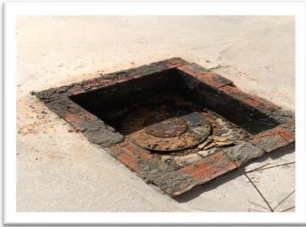
a) la tête de forage Guifla après la renouvellement
