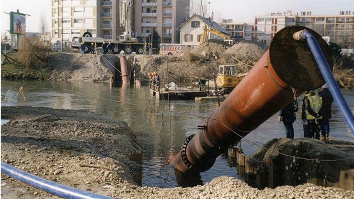
Figure VI.5: Traversée d'une rivière ( https://www.pamline.fr/catalogue/nos-produits/catalogue-annexes/reponses-techniques/mise-en-oeuvre/type-pose/pose-en-immersion )
