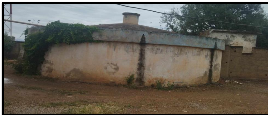
Figure VI.18 : Réservoir semi-enterré Thiouririne de volume 400 m 3
