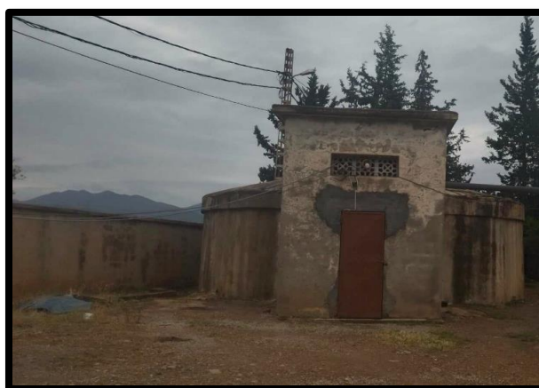
Figure VI.16 : Réservoir Idheriken de volume 200 m 3
