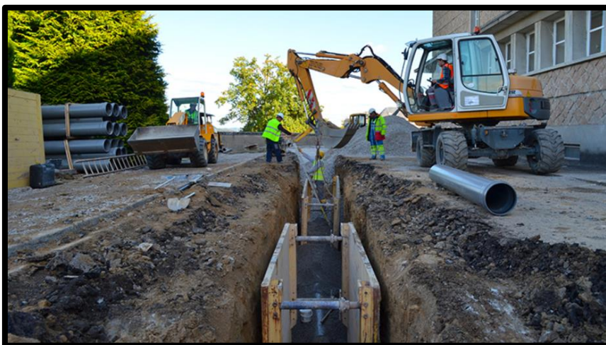
Figure VIII.1 : Pose de la conduite dans la tranchée
