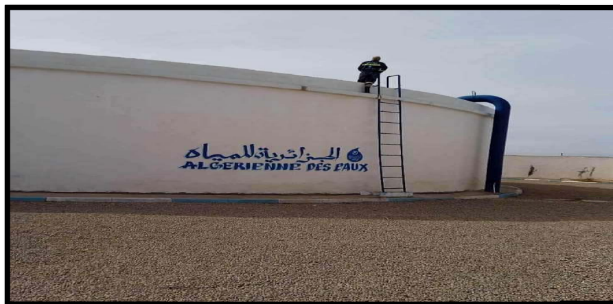
Figure III.7 : Travaux de peinture de réservoir 2500 m 3 à Khadret. (01 février 2024)
