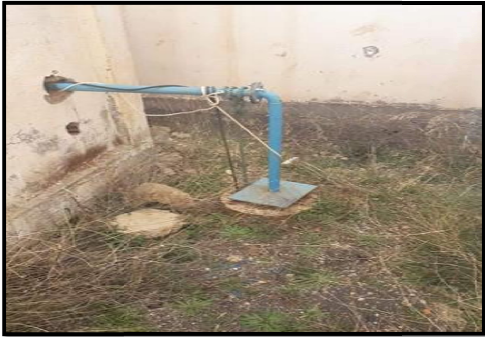
Figure III.4: L'abri de forage YATT 1 et ses équipements (2024)
