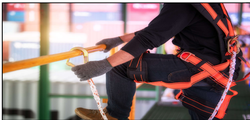
Figure VIII.3 : Protection des chutes
