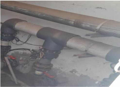
**Figure IV.1 :** câble de électrique non protégée
