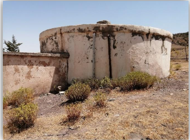
L'état extérieur du Réservoir 150 M 3
