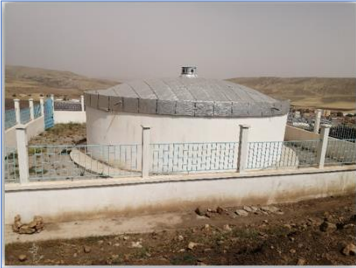
Figure 2.8 : Chambre des vannes de réservoir N°3
