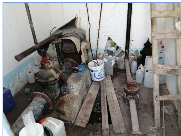
Figure 2.7 : La chambre de la vanne du réservoir N°2
