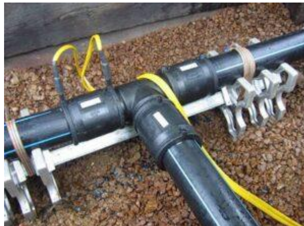
Figure VII. 4: Electro soudage des tubes en PEHD. (Source : strpepp.org )
