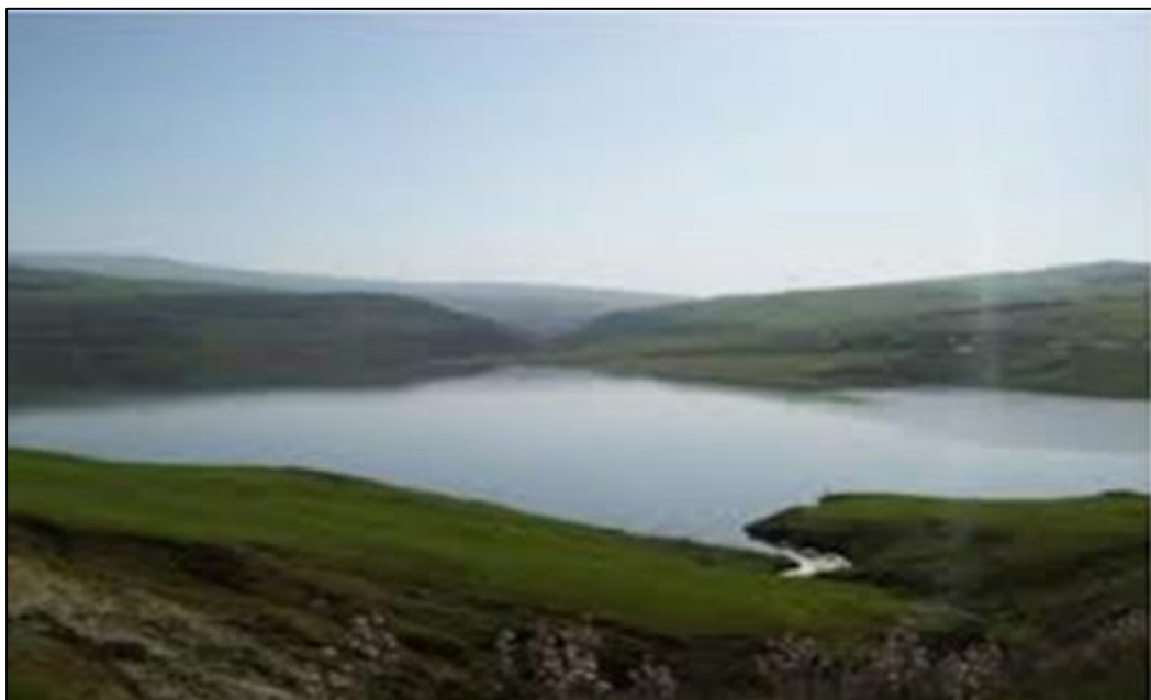
Figure II-1 : Barrage de draa diss.
