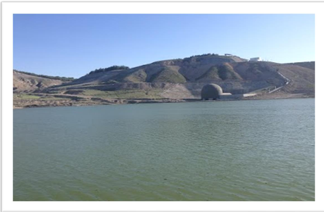
Figure II-1 : Barrage de Draa Diss (2020).
