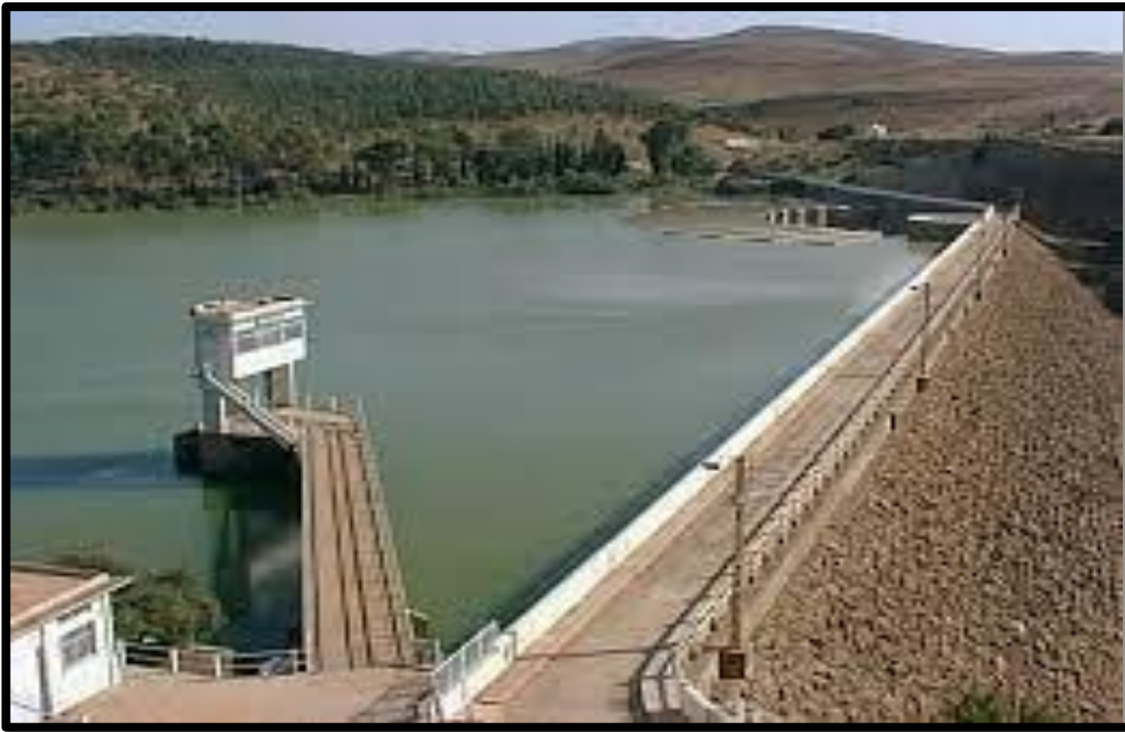
Figure II.5 Tour de prise du barrage de Boughrara
