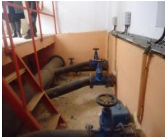
**Fig. V. 5 Une chambre de vannes**
