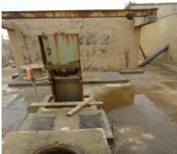
**Fig. V. 7 dégrilleur mécanique**
