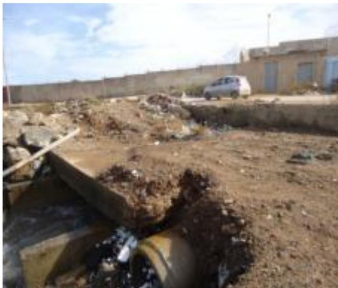
**Fig. V. 2 Deversoir d'orage qui se situe à l'amont d'un poste de pompage**
