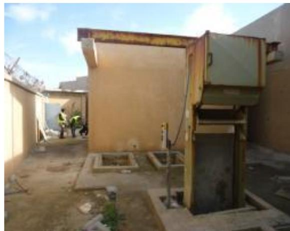
**Fig. V. 16 Un dégrilleur mécanique**
