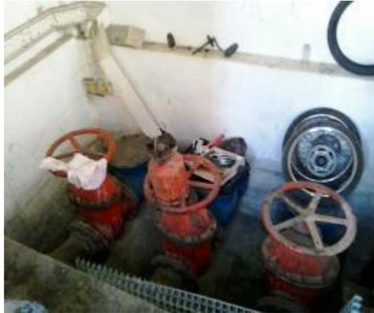
**Fig. V. 23 chambre de vannes**
