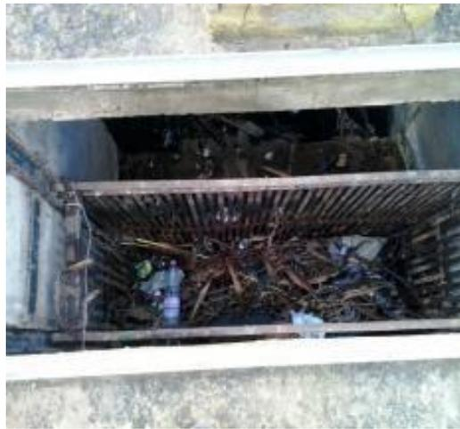
**Fig. V. 21 Un dégrilleur manuel .**
