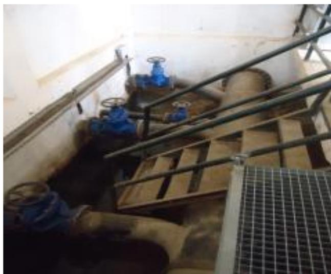
**Fig. V. 27 chambre de vannes**
