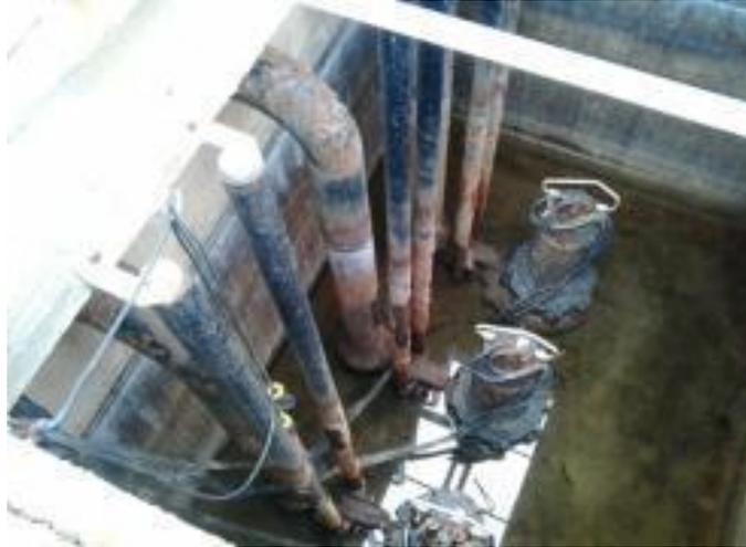
**Fig. V. 37** puisard équipé de trois pompes immergées
