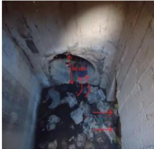
**Fig. V. 15 Deversoir d'orage avec une conduite de décharge**
