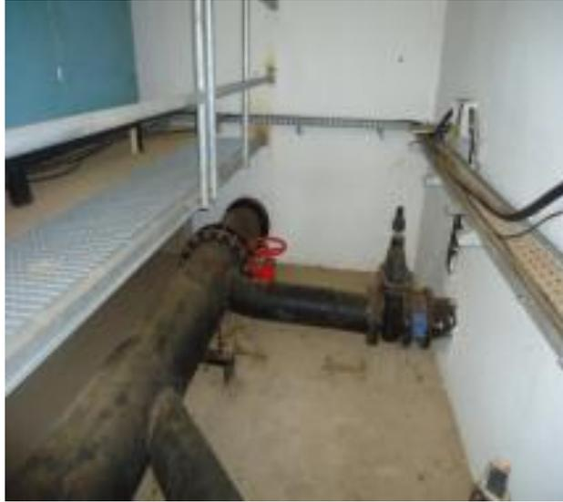
**Fig. V. 8 chambre de vannes**
