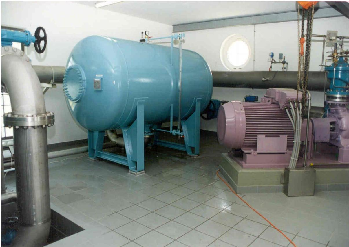
**Fig VIII. 3 Photo du dispositif anti bélier (type charlatte)**
