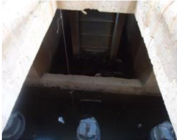
**Fig. V. 17 Un puisard équipé de trois pompes immergées**
