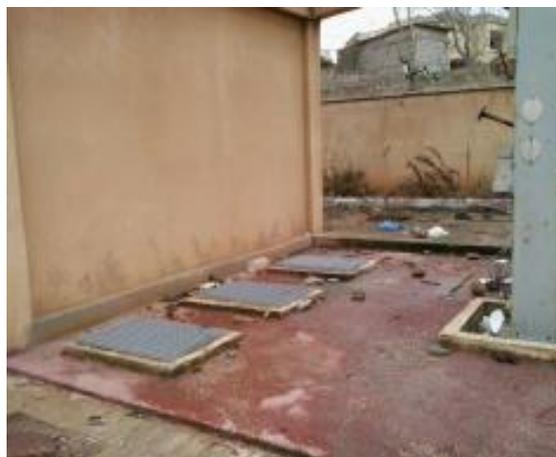
**Fig. V. 30 puisard équipé de trois pompes immergées**
