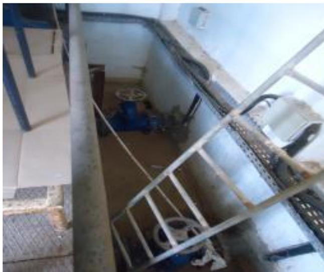
**Fig. V. 18 Une chambre de vannes**
