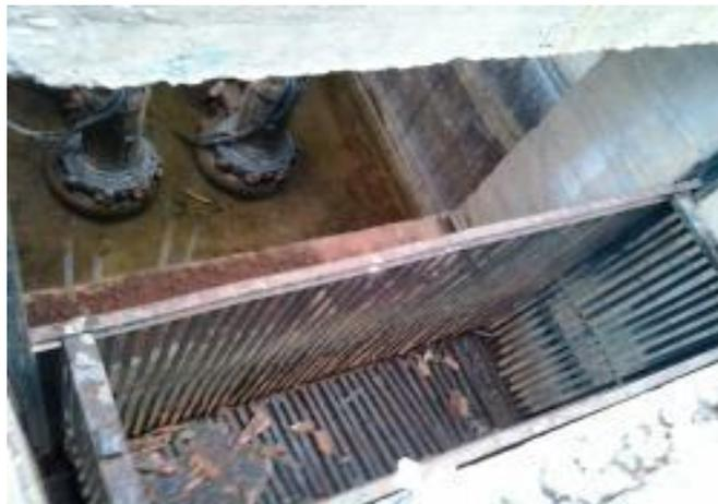
**Fig. V. 36 dégrilleur manuel**
