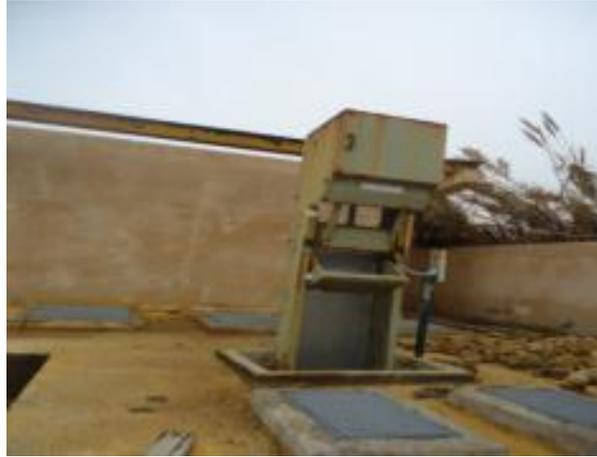
**Fig. V. 12 dégrilleur mécanique**
