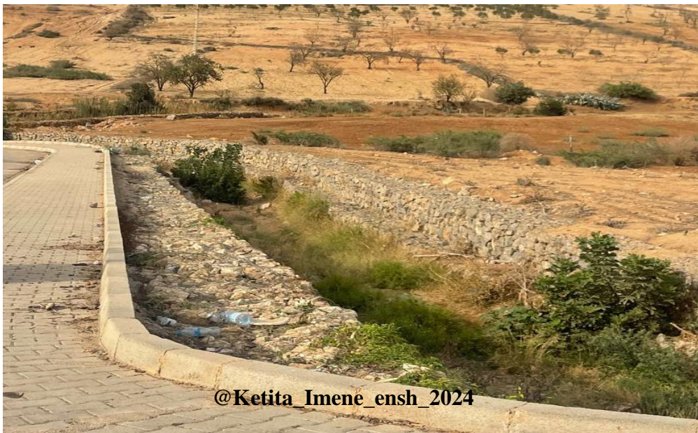
Figure V.13 : un exemple d'un gabionnage installé sur un Oued dans la commune de Bab El Assa W.Tlemcen (27/08/2024).
