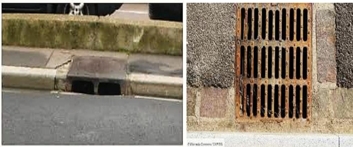
*Figure VII.5 Exemple d'une bouche d'égout (absorption par le haut)*
