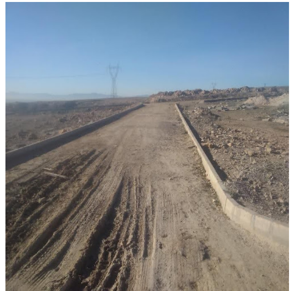
FIGURE 3.3 – Dégradation du lotissement due au débordement des eaux
