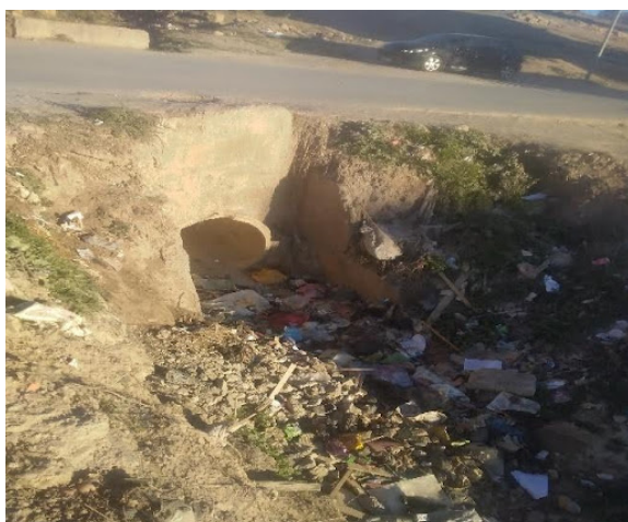
FIGURE 3.5 – Vétuste total de regard et canal
